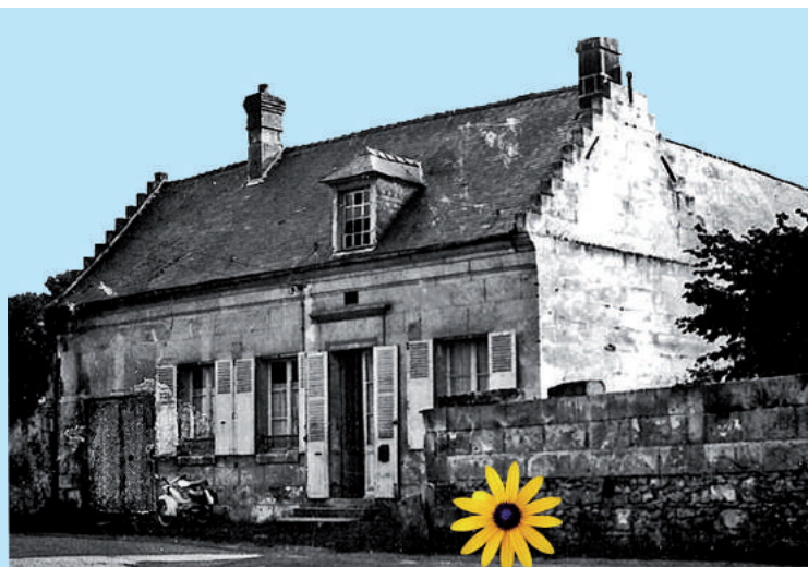
Das erste Arche-Haus in Trosly
